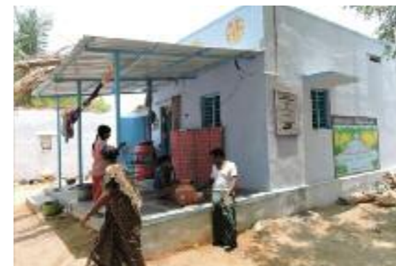
Una de las dos viviendas construidas gracias a la aportación de TECNIDEX
